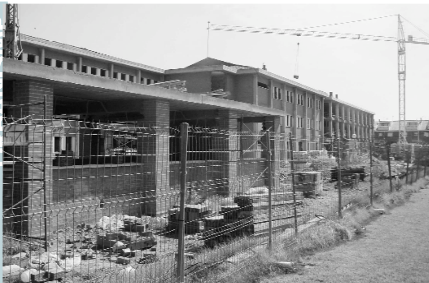
Nous blocs van "adossant-se" al vell edifici del qual tan sols es manté l'estructura
