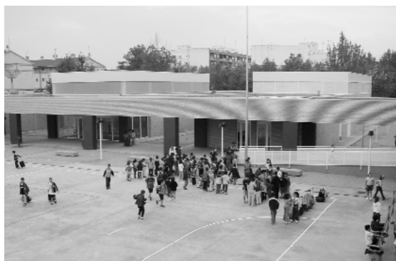
Nou corredor d'enllaç entre l'edifici principal i part de les noves instal·lacions: l'aula de primària, el gimnàs i el menjador de nova construcció
