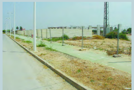
Obres de construcció dels habitatges adaptats
