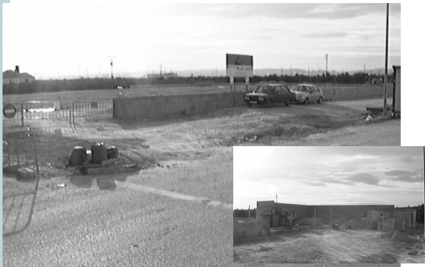
Vista general de les obres i parcial de l'edifici que servirà com a local d'assaig dels grups de música jove
